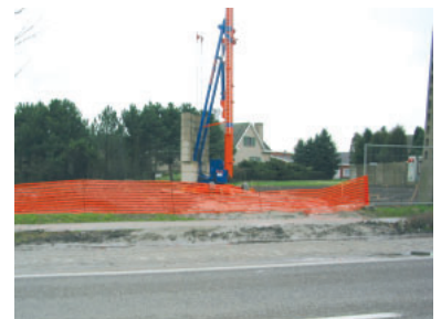
Oranje signalisatienetten volstaan niet als werfafsluiting
