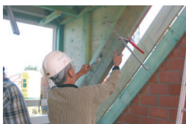
De plaatsing van een prefab dakkapel
