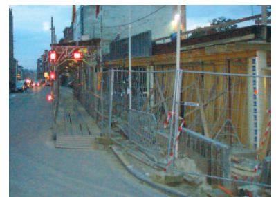
Het afbakenen van zones zodat voorbijgangers niet kunnen worden geraakt door vallende voorwerpen
