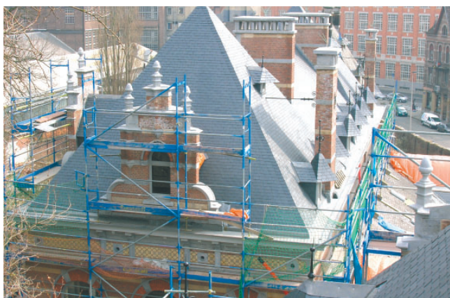
Het gebruik van steigers waarvan men beschikt over sterkteberekeningen
