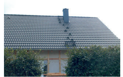
Het gebruik van ingewerkte treden in het dak
