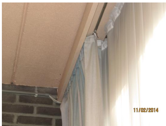
Bestaand railsysteem bureauruimte te verwijderen ifv nieuwe lamellen
