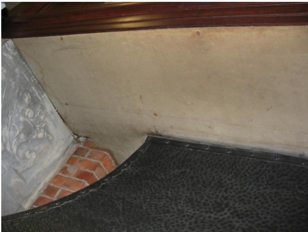
Foto 5: asbestcement plaat schouw lokaal 4
