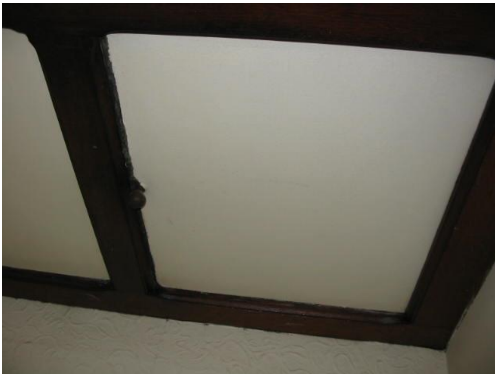
Foto 7: asbestcement plaat schouw lokaal 5
