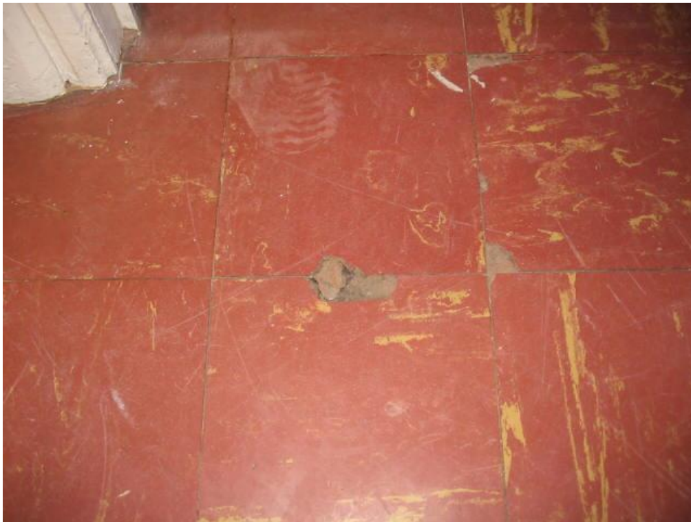
Foto 9: vinyltegels lokaal A
