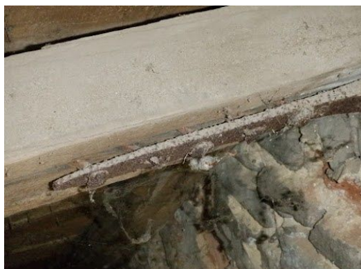
looskomende verbinding anker
