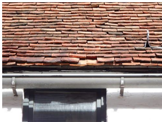
gebroken pan ter hoogte van de goot
