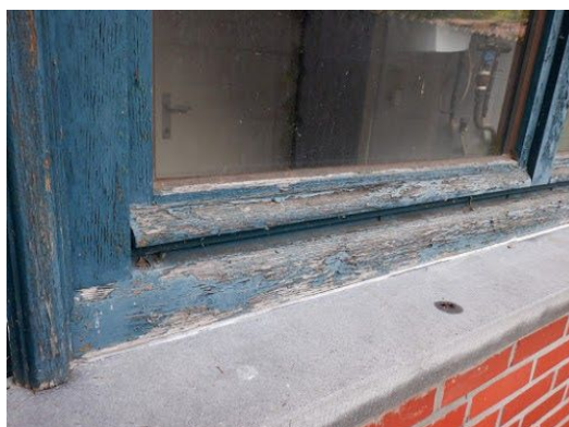
ontbrekende verflagen
