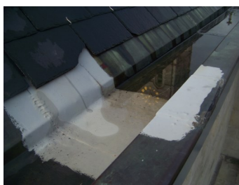
Duurzame herstelling met vloeibare EPDM.
