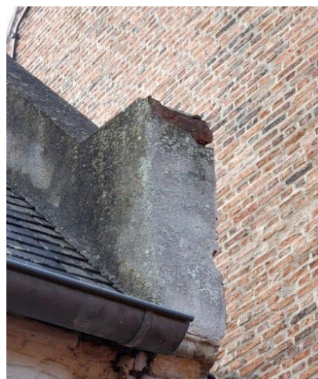
beschadigde aanstrijking op het bovendakse metselwerk
