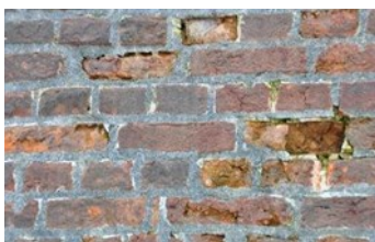
Een te harde voegmortel verstoort de vochtthuishouding, waardoor bakstenen sneller verweeren
