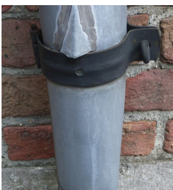
Controleer of de (scharnier-) beugels goed vast zitten. Een neus voorkomt dat onderdelen van de afvoerbuiz verzakken.
