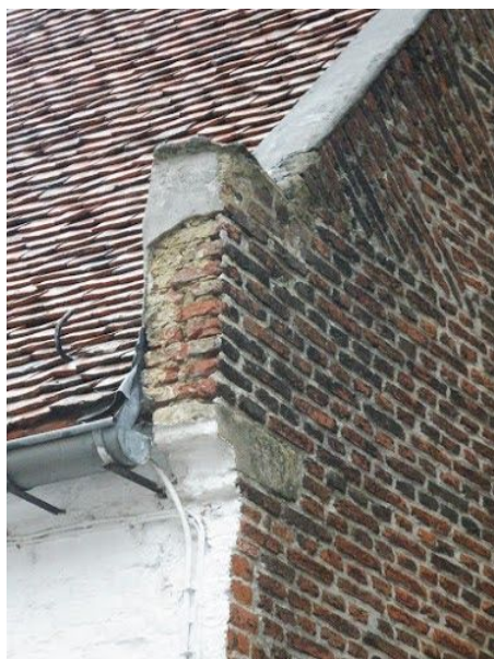
loskomende en afgevallen aanstrijking
