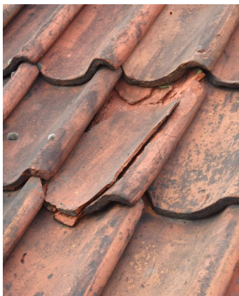
Afschilferende dakpan.
