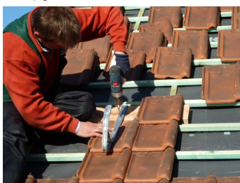
Aanbrengen van een ladderhaak.
