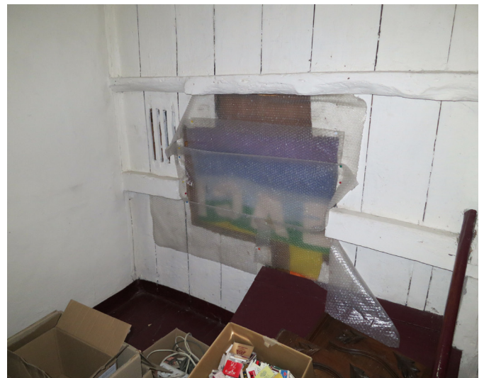
afb. 40 Opkamer met houten plankenwand
