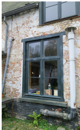
afb. 38 Buitenschrijnwerk achtergevel met te verwijderen afvoerleiding
