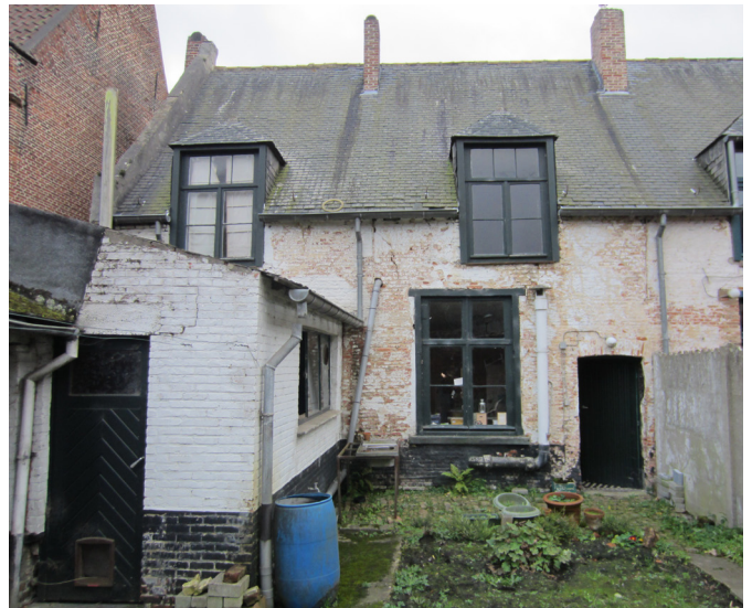
afb. 8 Achtergevel en achterbouw Kerkstraat 12
