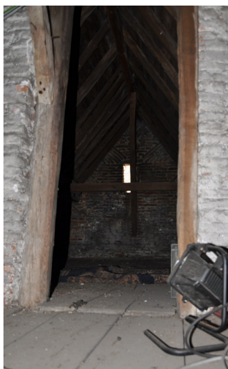
afb. 35 Gemene muur woning 10 - 12
