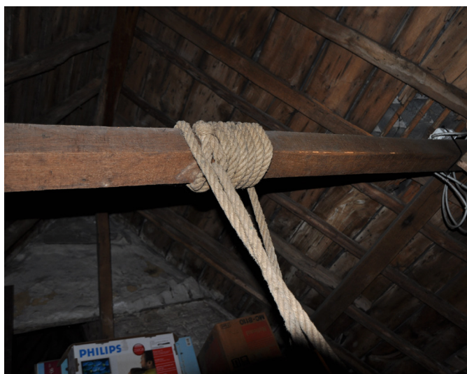
afb. 33 Dakconstructie, houten trekbal
