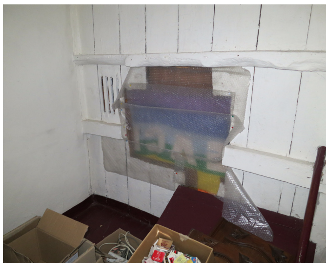
afb. 26 Opkamer met houten plankenwand
