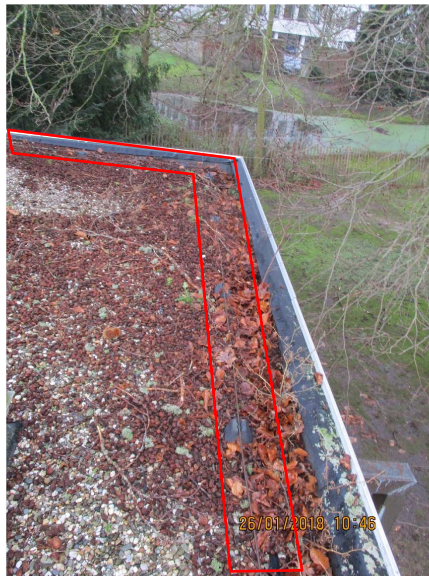
Assebroek_Gebouw TUA West_2018-01-26_02
