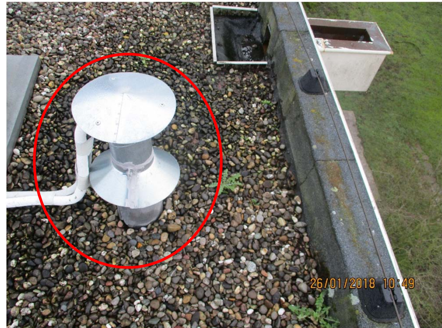
Assebroek_Gebouw TUA West_2018-01-26_06
