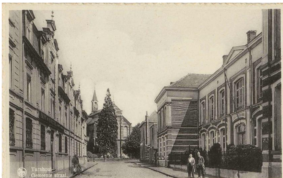
Figuur 6 Zicht op de Gemeentestraat na de verbouwing in 1923 met zicht op het Gasthuis
