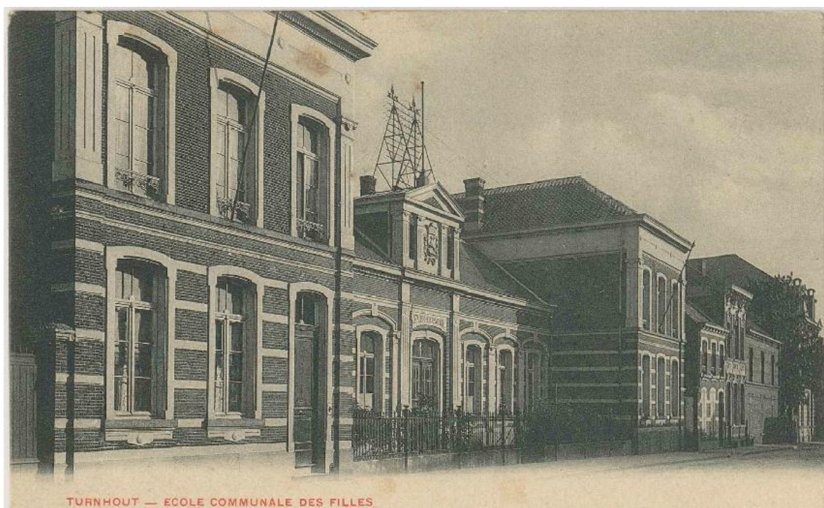
Figuur 2 Oorspronkelijke gevel van het gebouw van de stedelijke meisjesschool zoals ontworpen door Taeymans omstreeks 1900. (Collectie Stadsarchief Turnhout, Prentbriefkaart 47_008)
